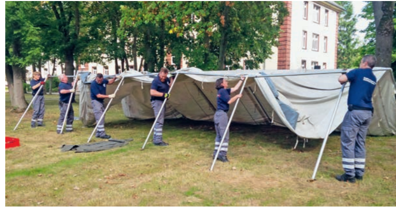
Im Einsatz Anlässlich des Kasernenfestes am Niedersachsendamm baut die DRK-Bereitschaft ein Zelt für die Besucher auf.
