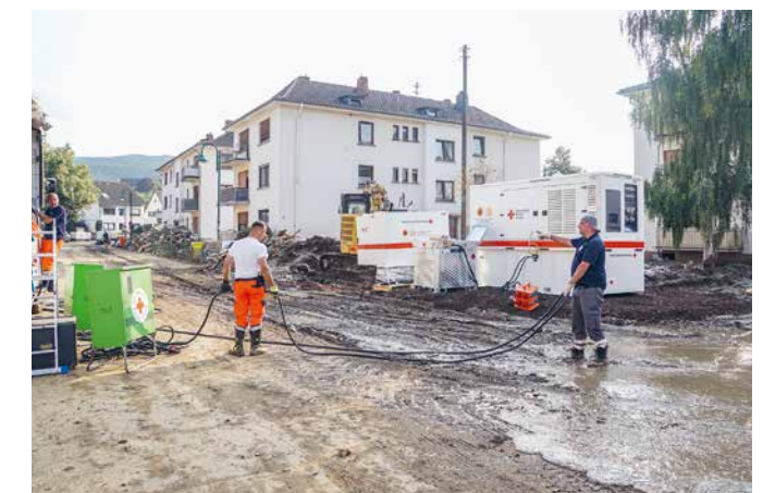
Mitte: Vorbereitung für die Versorgungsfahrten – DRK-Mitarbeiter beim Beladen der geländegängigen Lkw des Kreisverbandes Bremen Unten: Aufbau einer provisorischen Stromversorgung in einem Wohngebiet in Ahrweiler
